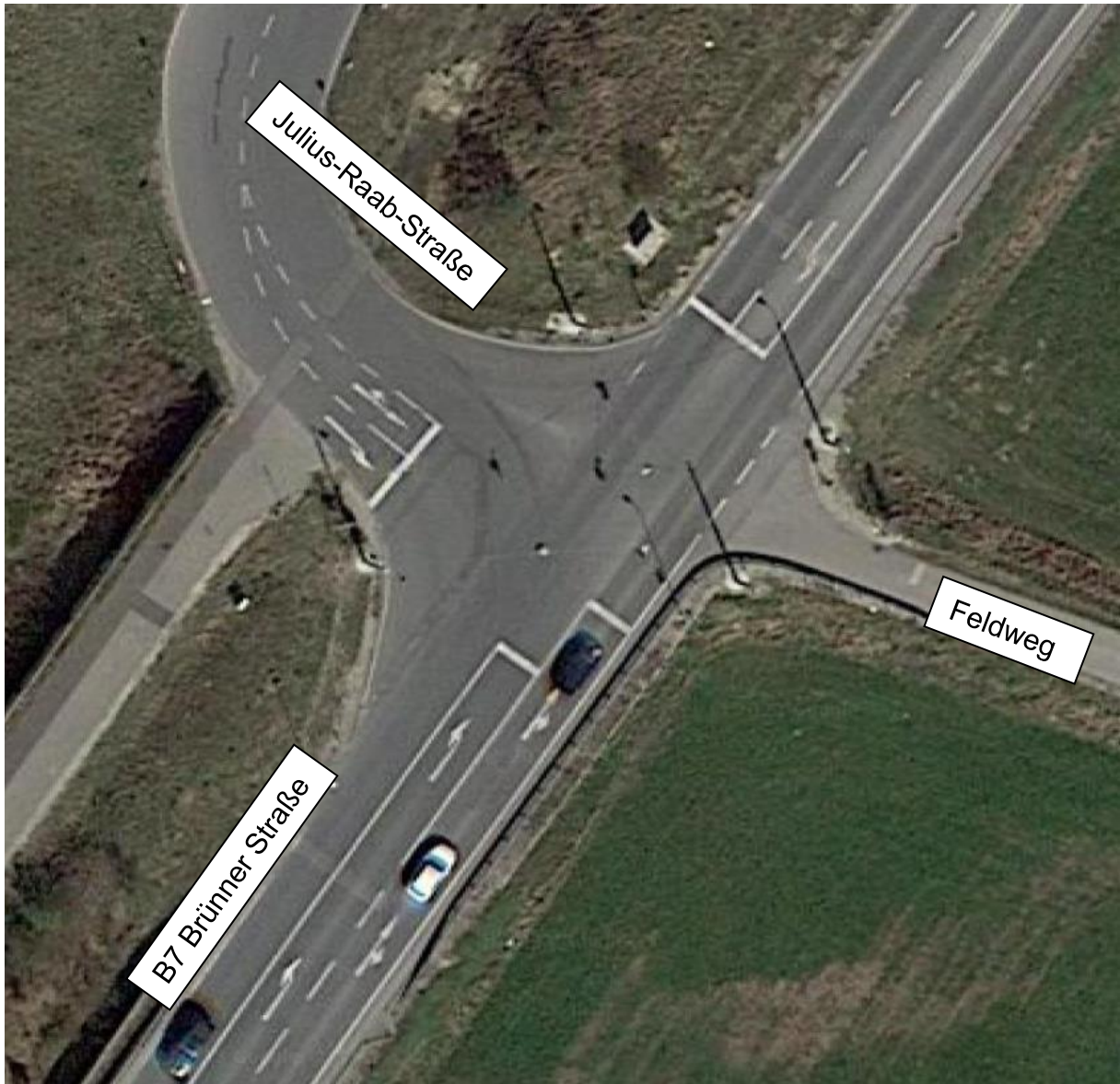
Abbildung 24: Luftbild B7 Brünner Straße / Julius-Raab-Straße
